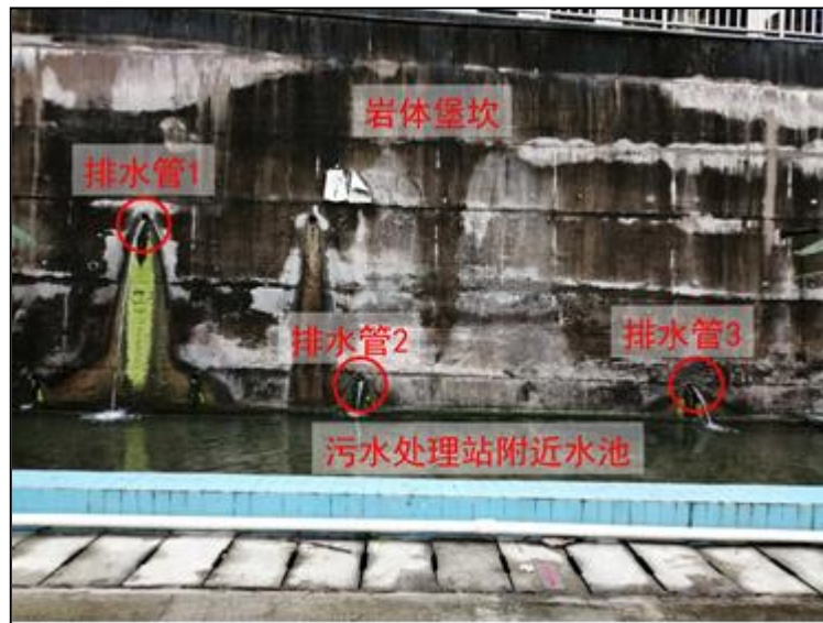
图 4-2 污水处理站附近堡坎、水池和排水管
