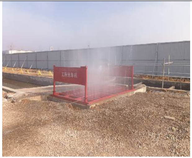
施工车辆清洗
