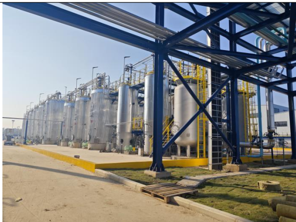
调合工艺装置区围堰
