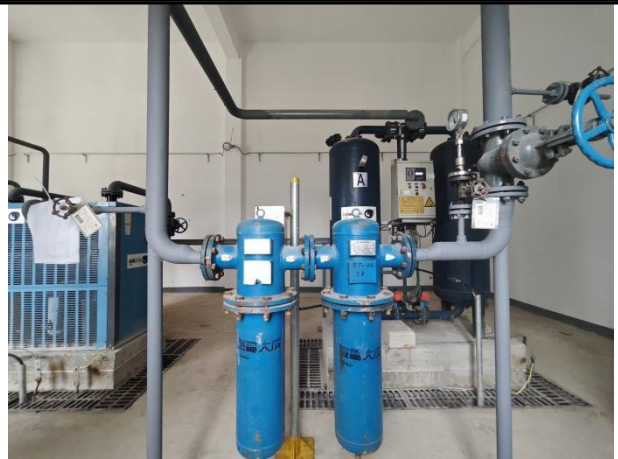
空压设备基础减振
