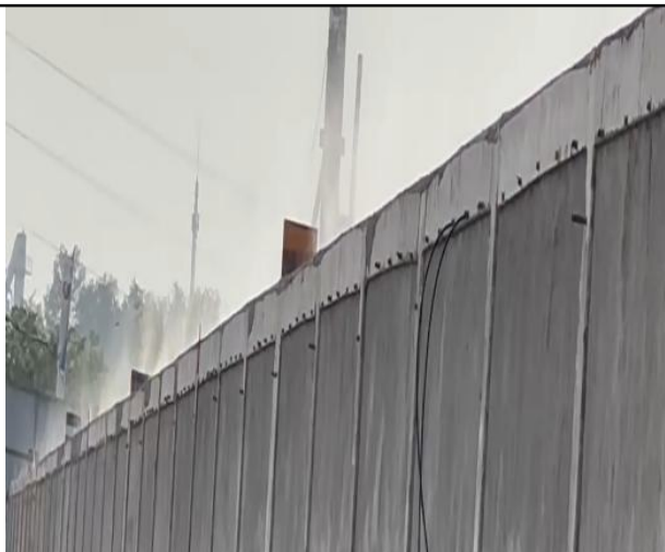
施工围挡及喷淋系统
