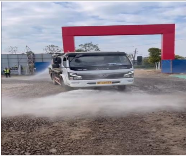
施工场地洒水
