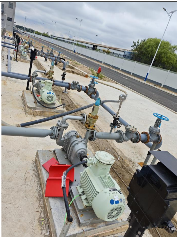
雨水、污水提升泵及闸阀
