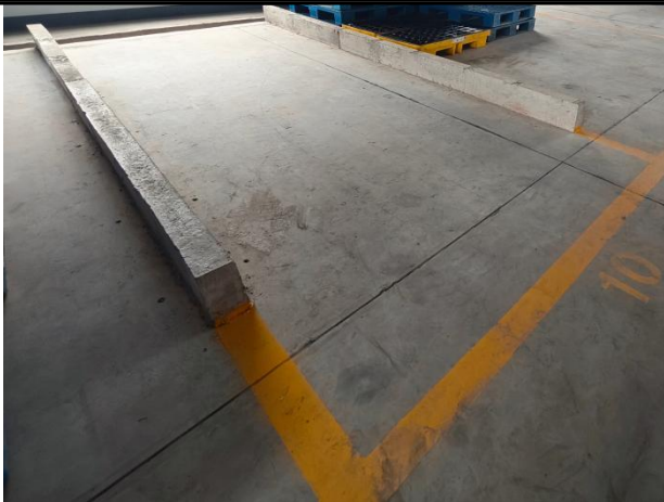
分隔堰及标线
