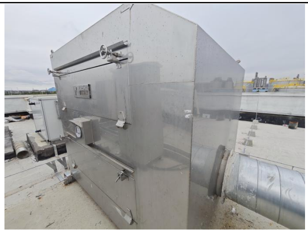
油雾冷凝机+活性炭吸附装置（TA002）
